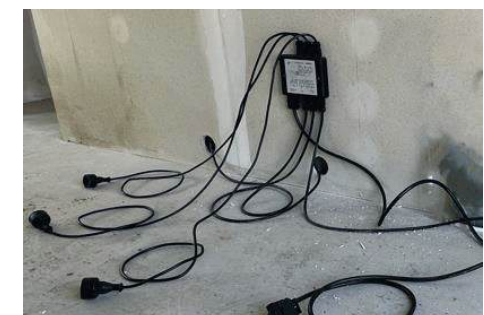
Voorbeeld keukenverdeler met aangesloten kabels
